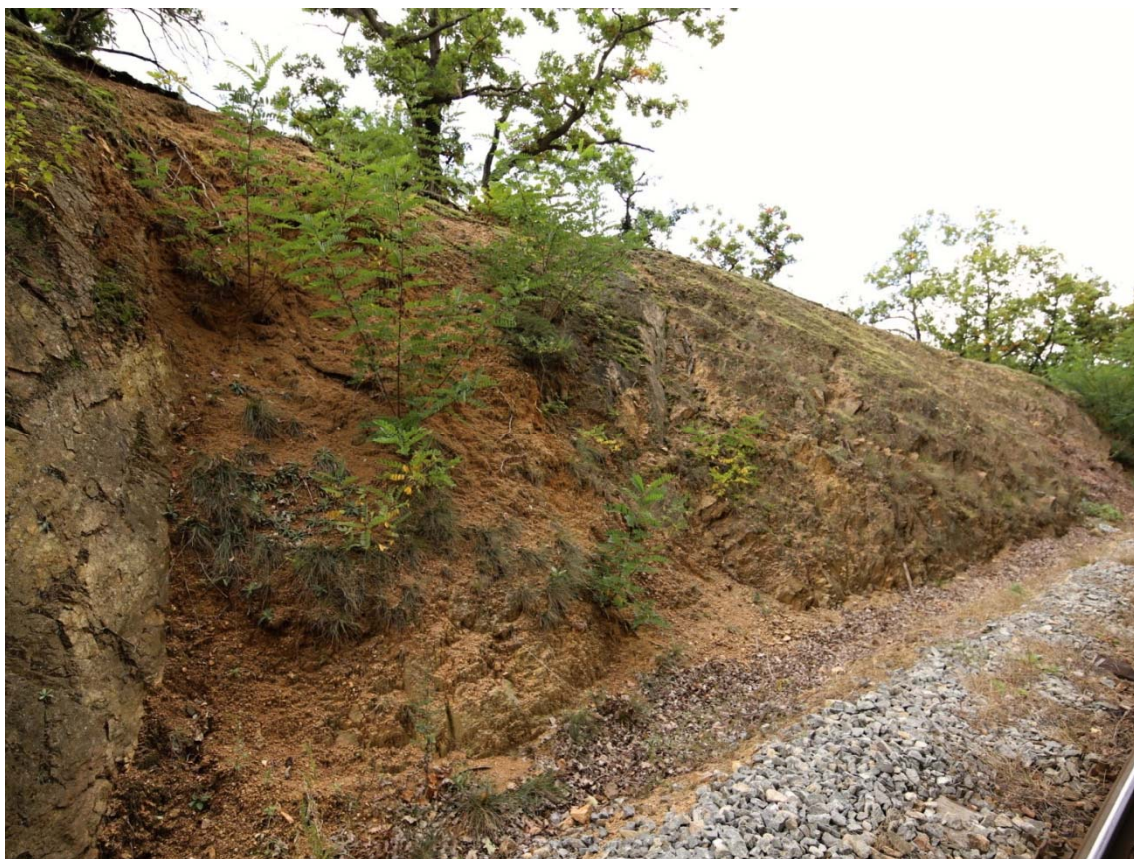
Obrázek 5: Příklad rozpadu levostranného svahu podél výrazné poruchy, charakter písku
