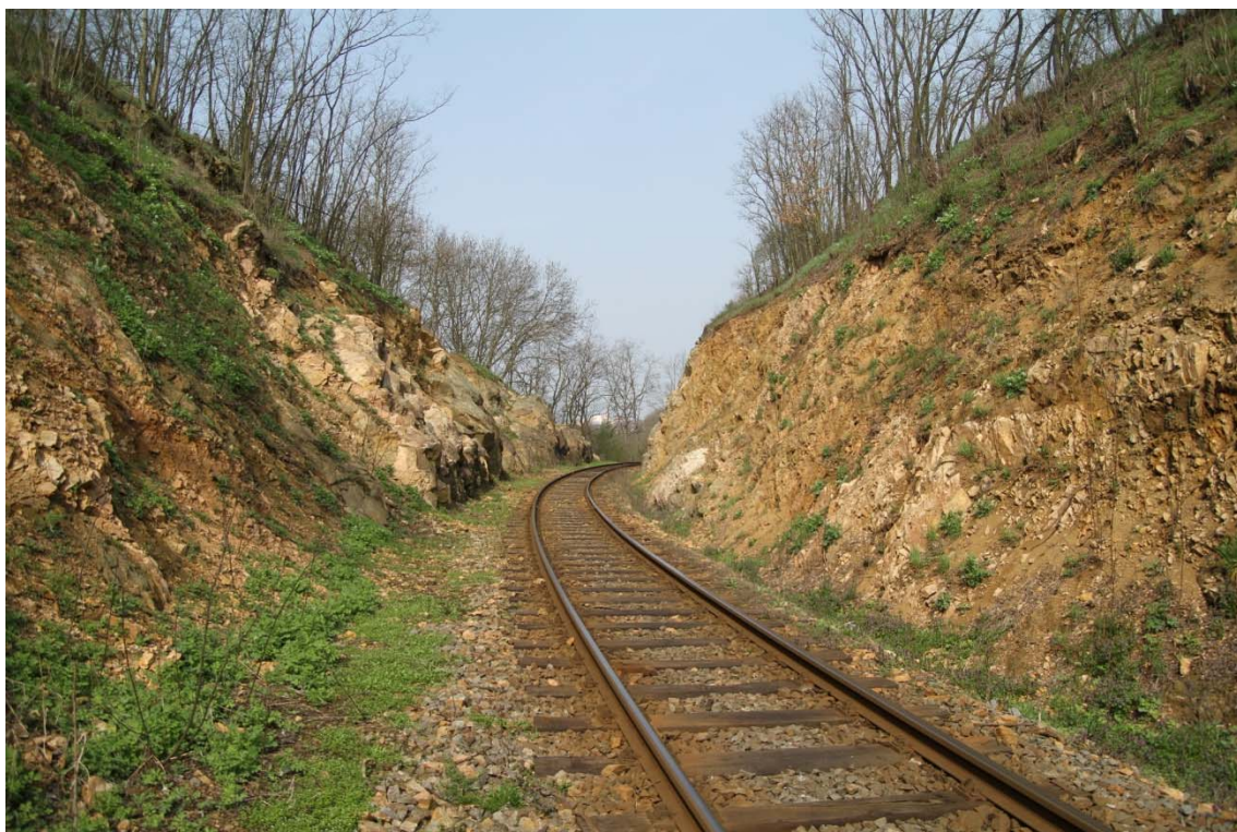
Obrázek 16: povaha masívu po očištění, pohled směr Ivančice, dnešní stav pravostranného svahu značně degradován
