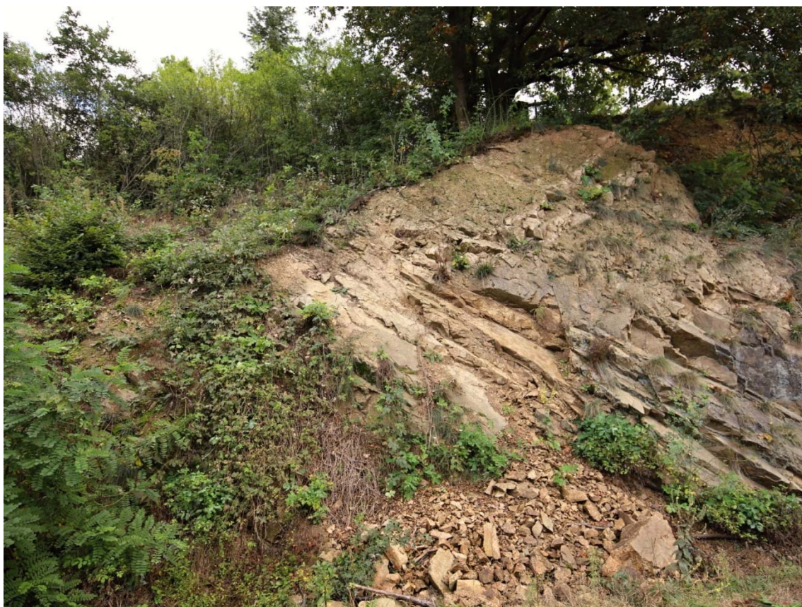
Obrázek 6: Příklad rozpadu a neustálého opadu masívu v km 1,485 vpravo
