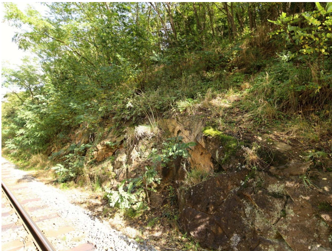
Obrázek 8: Stav rozpadu masívu v km 1,740 s velmi hustým vegetačním porostem
