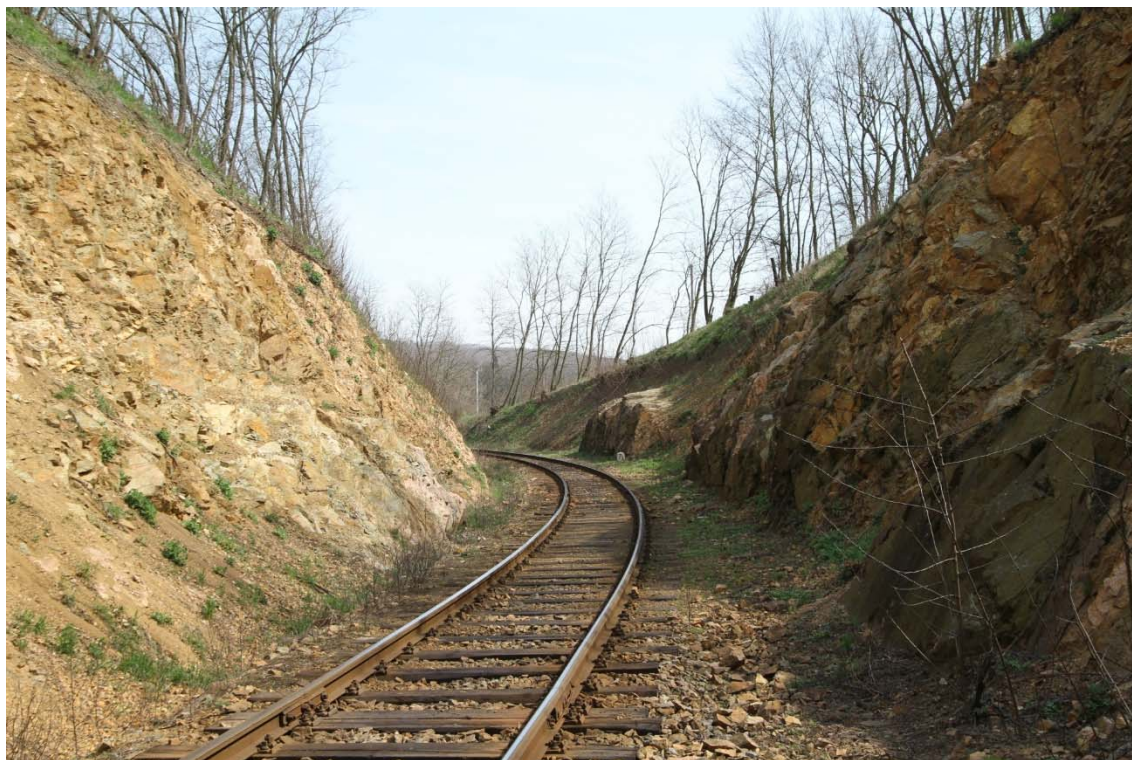
Obrázek 14: povaha masívu po očištění, pohled směr Moravské Bránice, dnešní stav pravostranného svahu značně degradován (vlevo)
