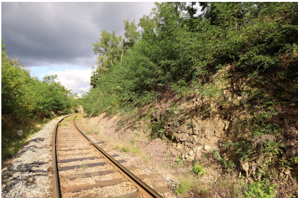
Obrázek 1: Pohled na stav zářezu v km 1,400, zvláště silně zvětralá pravá strana, velmi hustý porost vegetace, směr Ivančice
