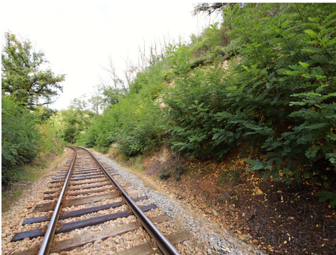
Obrázek 11: porucha pravého svahu v km 1,880, horní odtrhová linie svahu je na cizím pozemku, riziko pádu masivních hmot, hustý kryt vegetace
