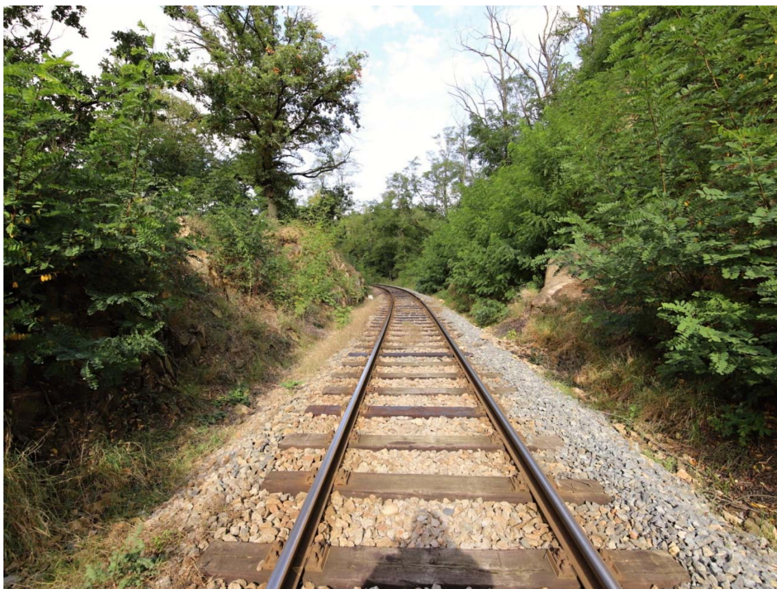
Obrázek 12: pohled na koncovou část zářezu směr Ivančice, na pravé straně známky proběhlého řízení a opadu a zavalení příkopu
