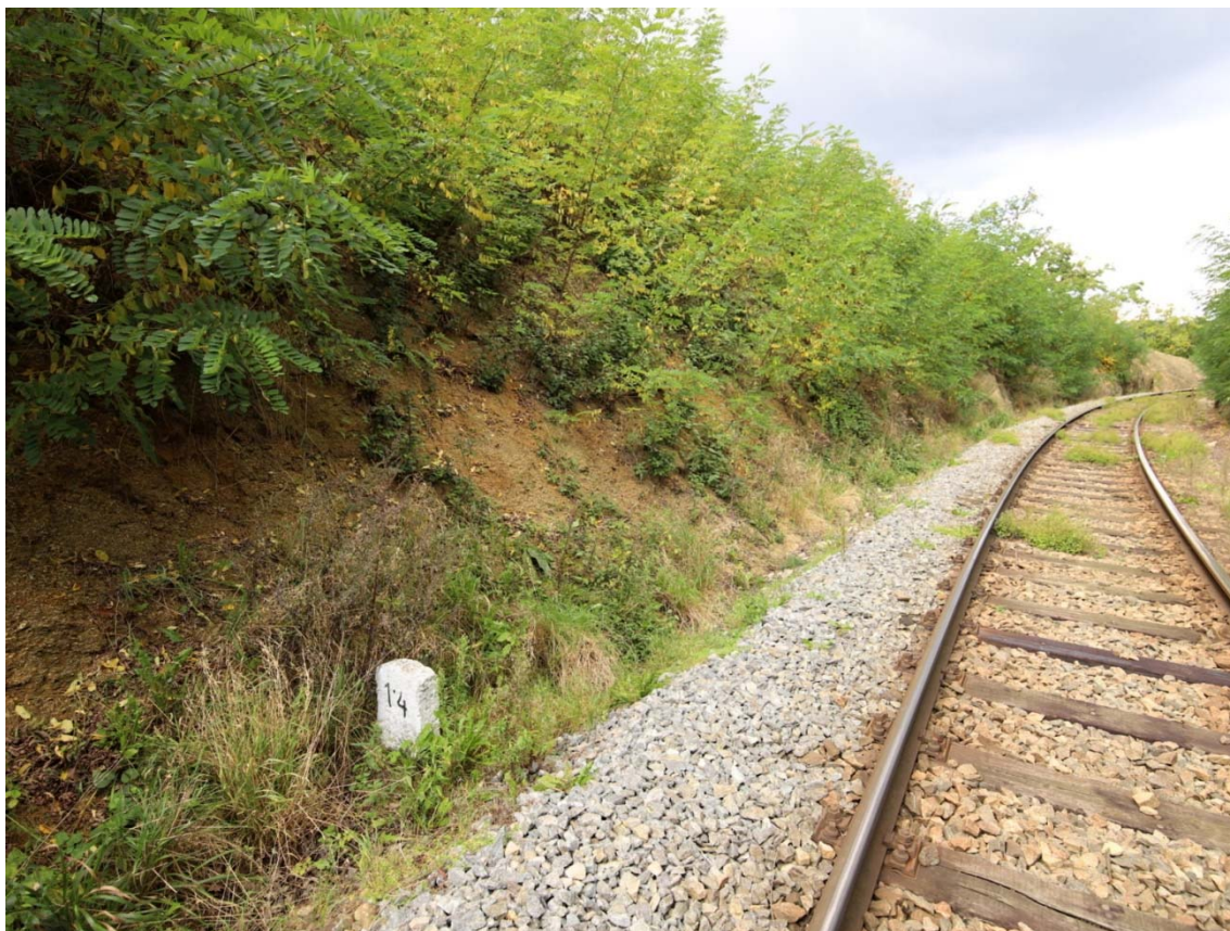
Obrázek 2: Pohled na stav zářezu v km 1,400, levá strana se zcela zvětralým masívem, směr Ivančice
