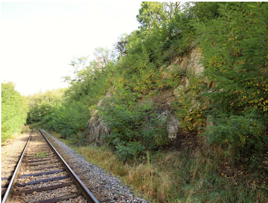
Obrázek 7: stav pravostranného svahu v km 1,550 s rizikem masivního řícení, značně kryto vegetací
