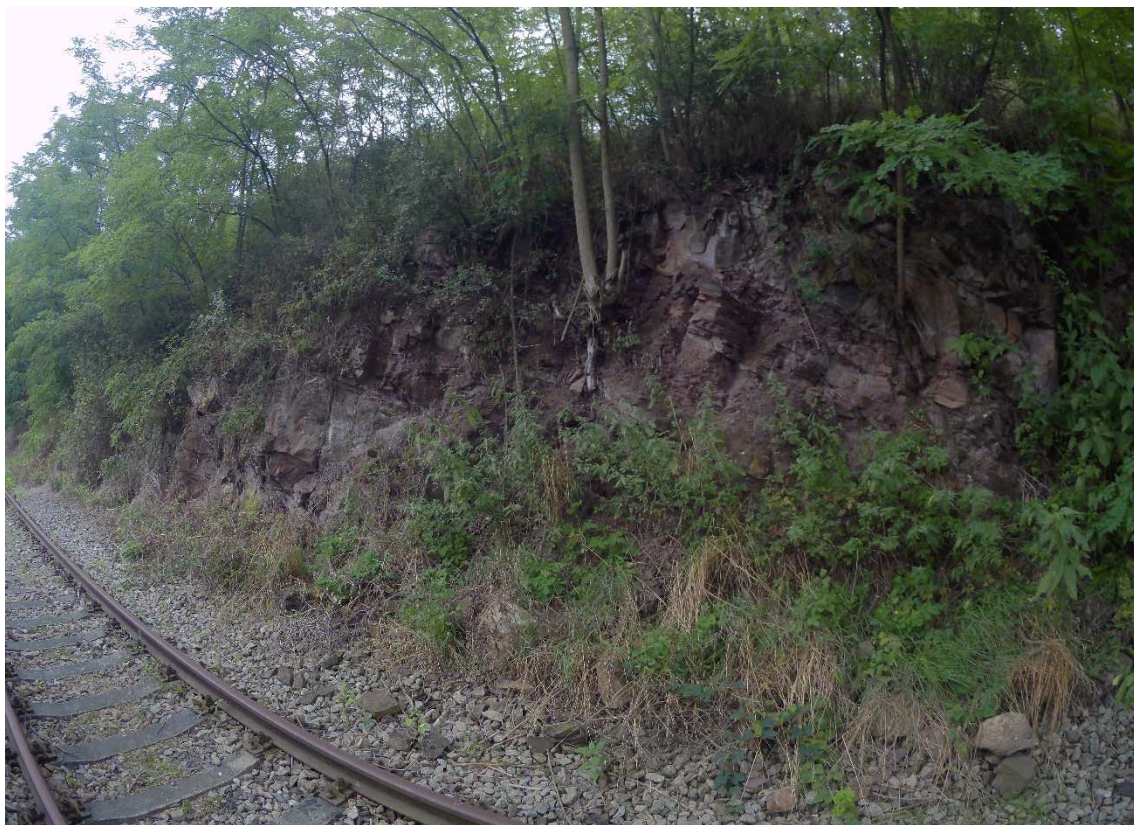
Obrázek 18: příklad degradace a rozpadu masívu a vliv vegetace na rozpad masívu
